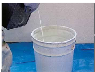
混練容器にエマルジョン投入
