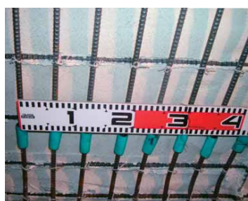
補強鉄筋取付工
