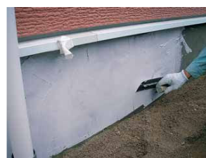
上塗り材塗布工
