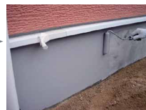
仕上げ材塗布工
