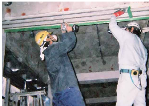
【梁下面の配筋状況】
