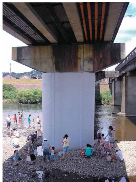
【鋼板巻立ての防錆塗装】
