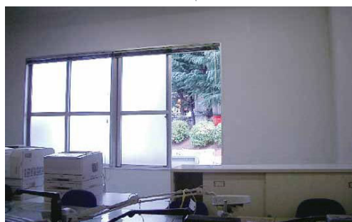
施工後(ワイヤーメッシュ塗り込み)
