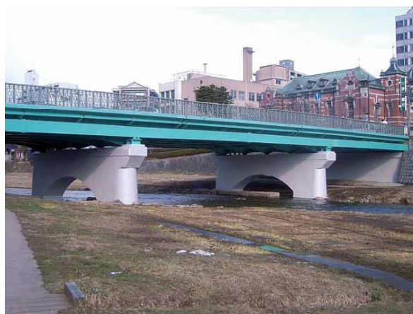
【不定形橋脚での施工例】
