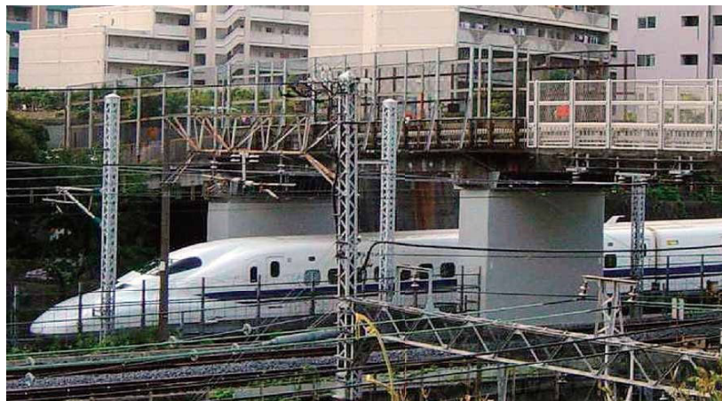
【建築限界の厳しい施工例】
