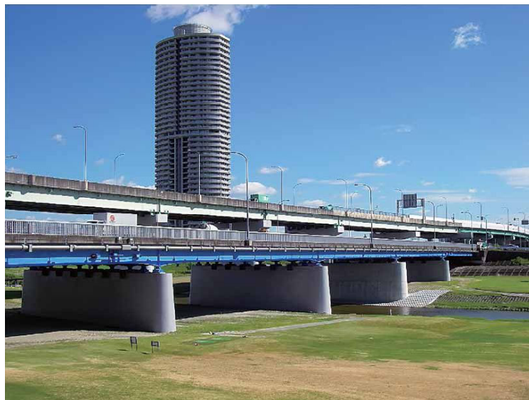
【河積阻害率の制約下での施工例】
