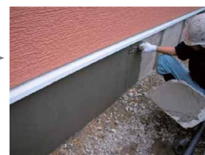
下塗り材塗布工
