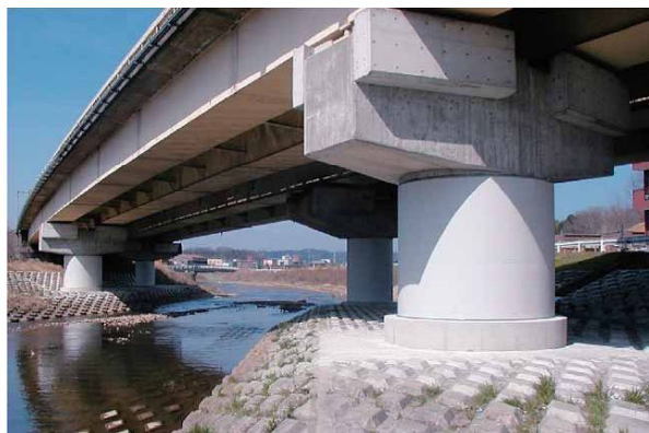
【鋼板巻立ての防錆塗装】
