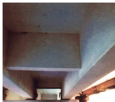
【主桁・床版の補強】
