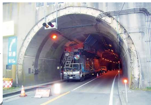
施工中(足場状況)
