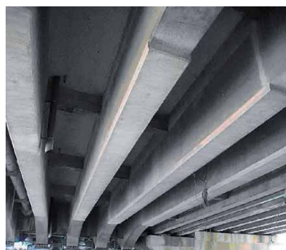
【RC主桁の補強】
