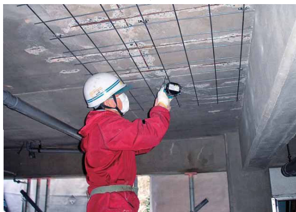
スラブ下面への補強筋配置
