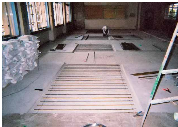
【スラブ上面の配筋状況】
