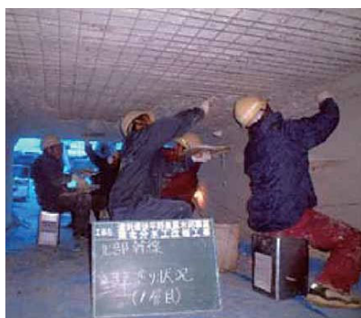
【ボックスカルバートの頂版補強】
