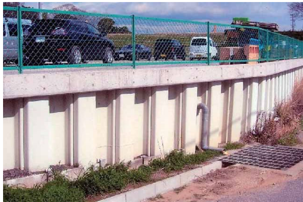
【鋼矢板の防錆】
